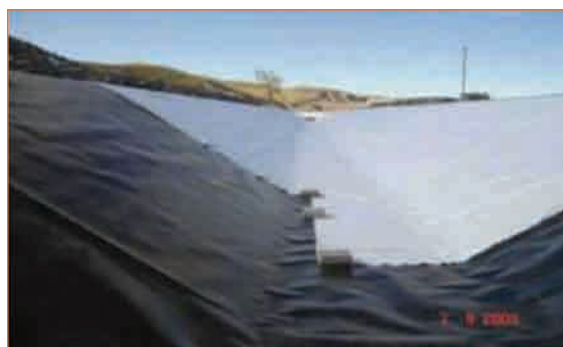
Зураг 57. Сувгийг геотекстел, геомембранаар доторлож байгаа нь
