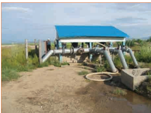
Зураг 53. Бороожуулах машины шахуурга станц ба АНУ-д үйлдвэрлэсэн “Valley” бороожуулах төхөөрөмж
