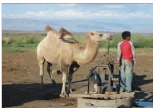
Зураг 8. Унд, ахуйд ашиглаж буй эвдэрсэн бетон хашлагат уурхайн худаг
