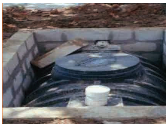
Зураг 20. Септик танкийг суурилуулахын өмнөх ба газарт суурилуулсаны дараах байдал
