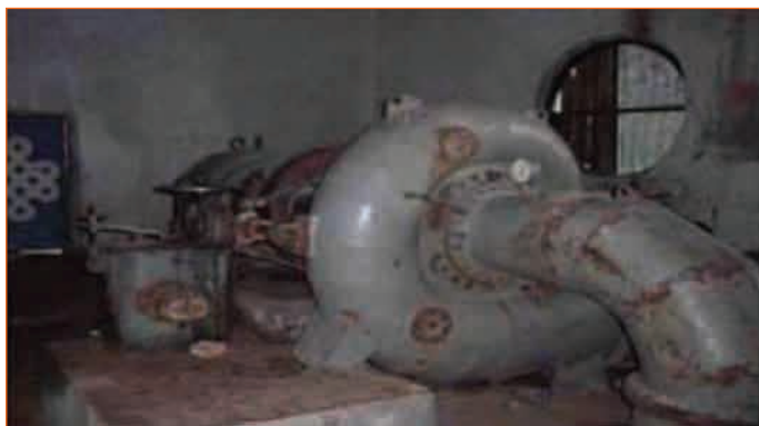
Зураг 77. Хэвтээ тэнхлэгт турбин генератор
