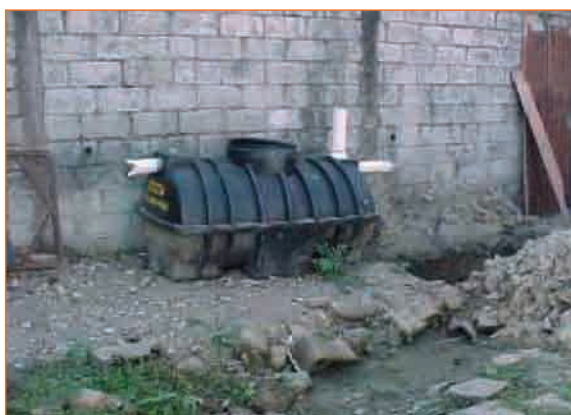
Зураг 20. Септик танкийг суурилуулахын өмнөх ба газарт суурилуулсаны дараах байдал
