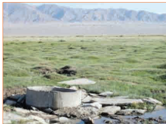
Зураг 11. Бэлчээр дэх эвдэрч тоногдсон өрөмдмөл худаг ба бетон хашлагат худаг
