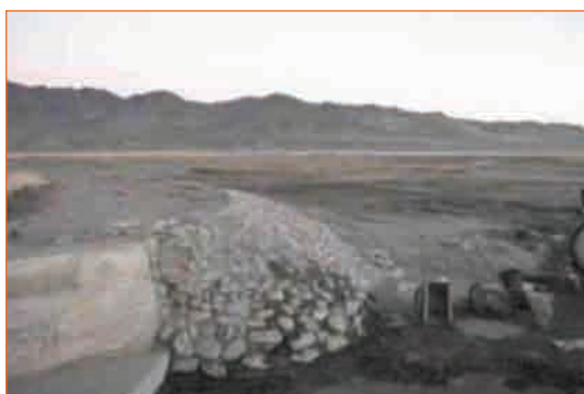
Зураг 67. Ус татамжтай холбогдох хэсэг 30 м урт чулуут бетоноор хийсэн далан
