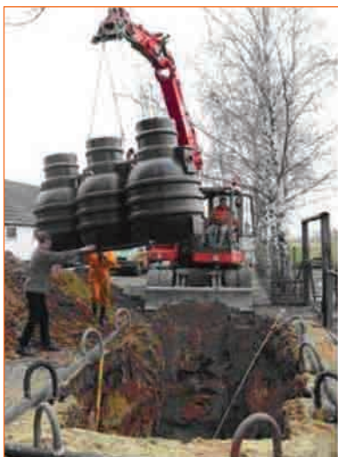
Зураг 21. Септик танк суурилуулж байгаа нь
