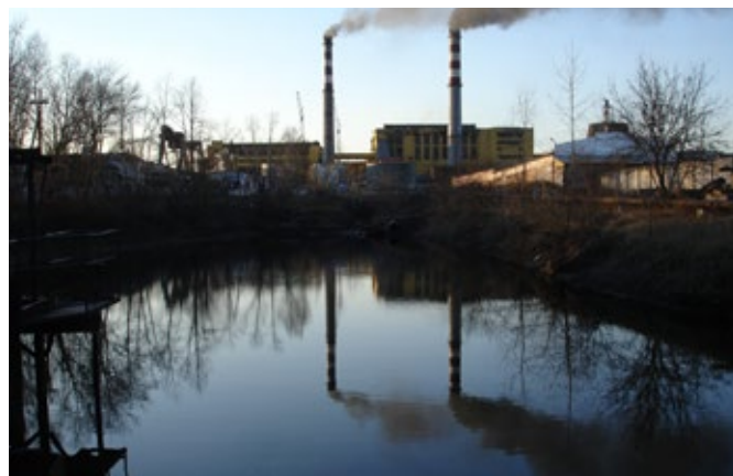
Рис. 4.2.9 Очистные сооружения ТЭЦ г. Улан-Удэ
